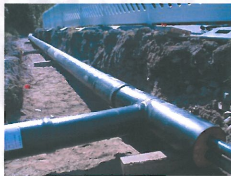
Kuva 1 ja 2: Tammitien ja Pyyhkäläntien kaukolämpölinjojen rakentaminen
