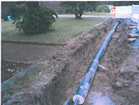
Kuva 1 ja 2: Tammitien ja Pyyhkäläntien kaukolämpölinjojen rakentaminen
