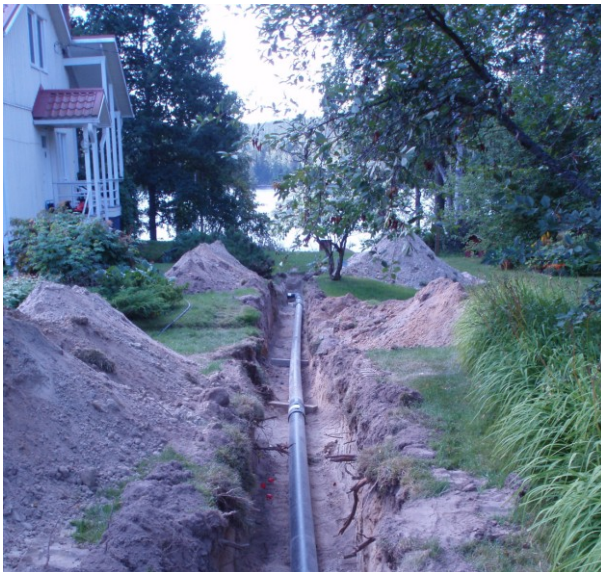
Kuva 4: Talojohdon asennus Keski-Nisula
