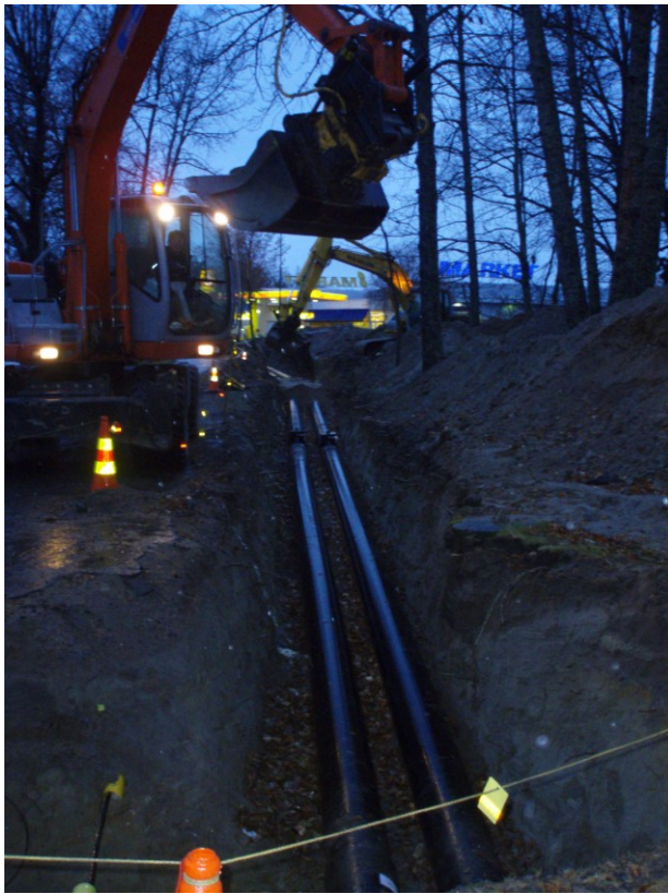
Kuva 5: Siirtolinjan rakentaminen SOKOS- uusi asemalaitos, KPL 2
