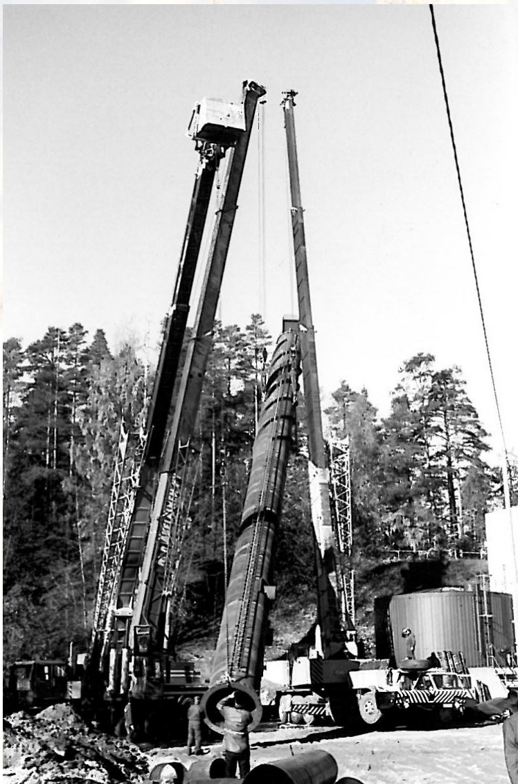
Kuva 4: KPA-lämpölaitoksen savupiipun pystytys vuonna 1988
