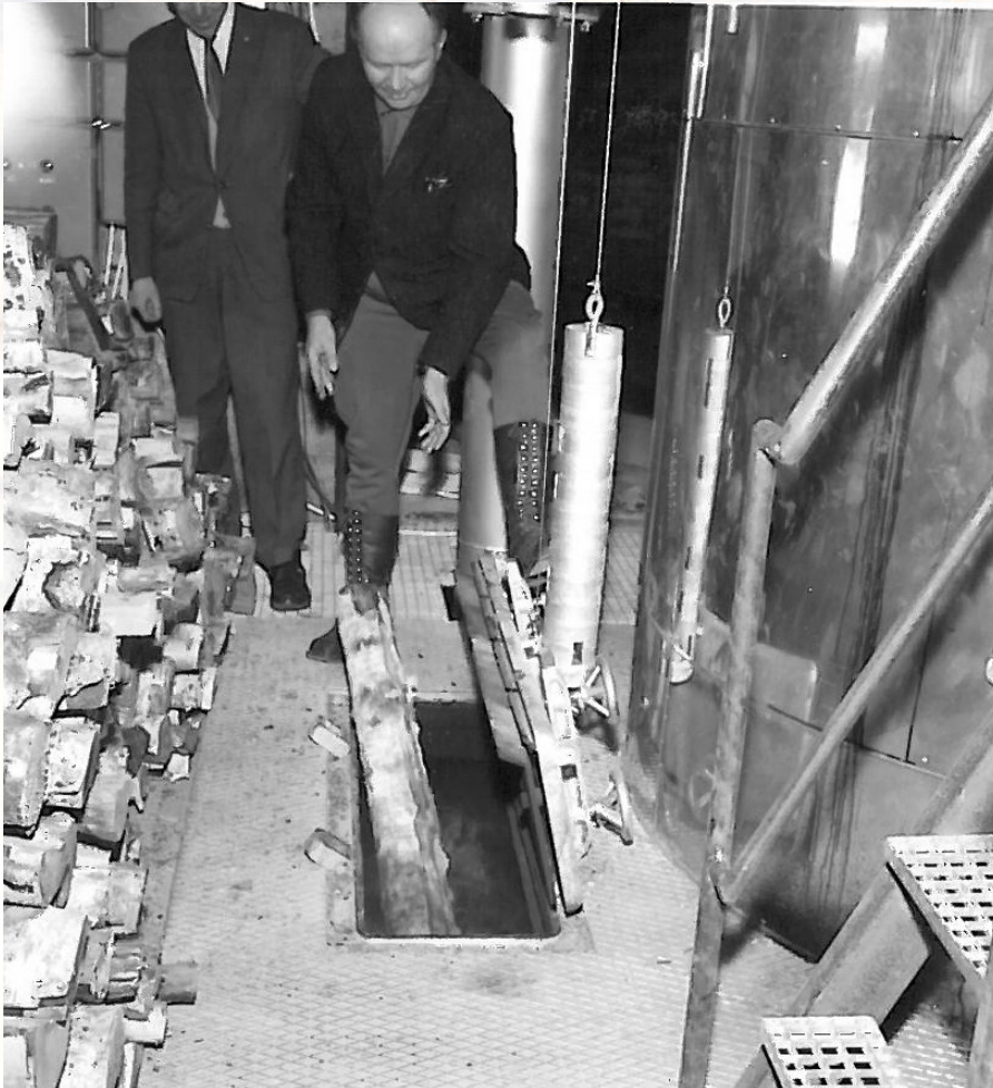
Kuva 3: Ossi Marttila heittämässä halkoja lämmityskattilaan.
