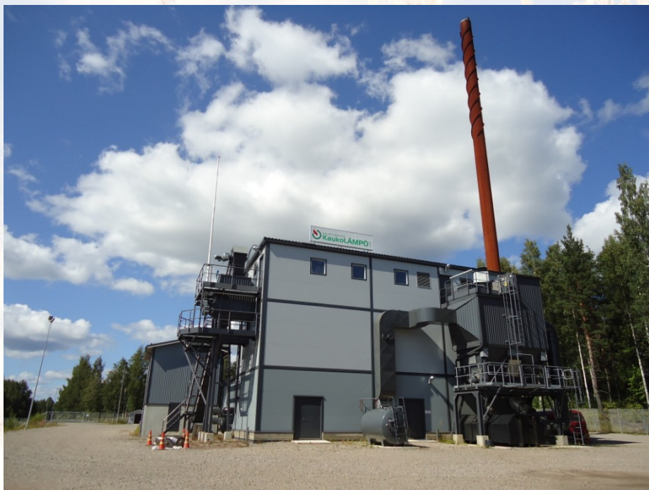
Kuva 5: Vuonna 2009 valmistunut kotimaista polttoainetta käyttävä kaukolämpölaitos
