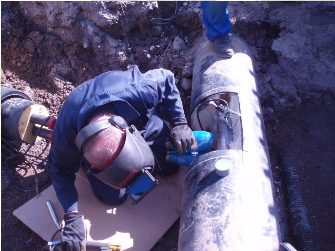
Kuva 3: Kaukolämpörunkolinjan rakentaminen
