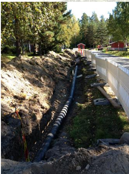
Kuva 1 ja 2: Koiralammen alueen kaukolämpölinjojen rakentaminen
