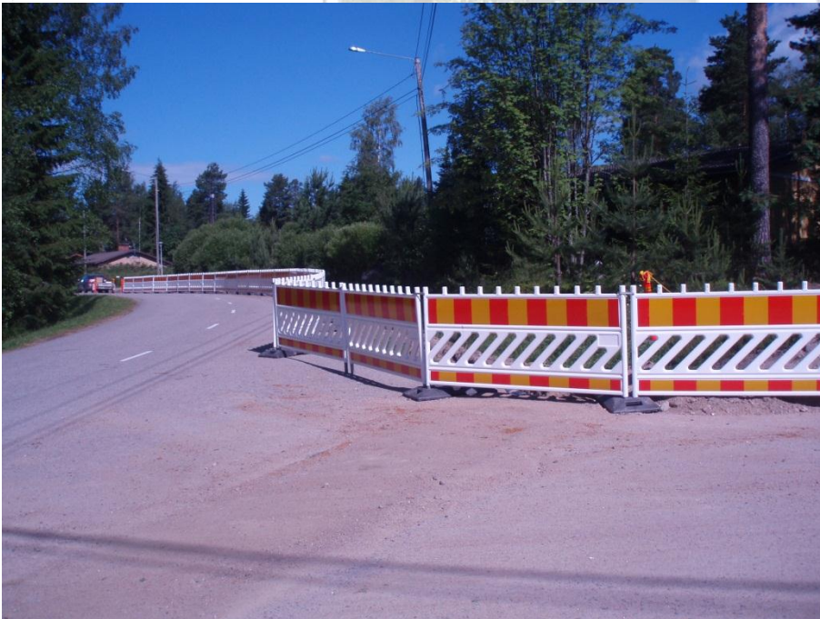
Kuva 5: Kaukolämpörunkolijan työmaan kevyenliikenteen suojaus
