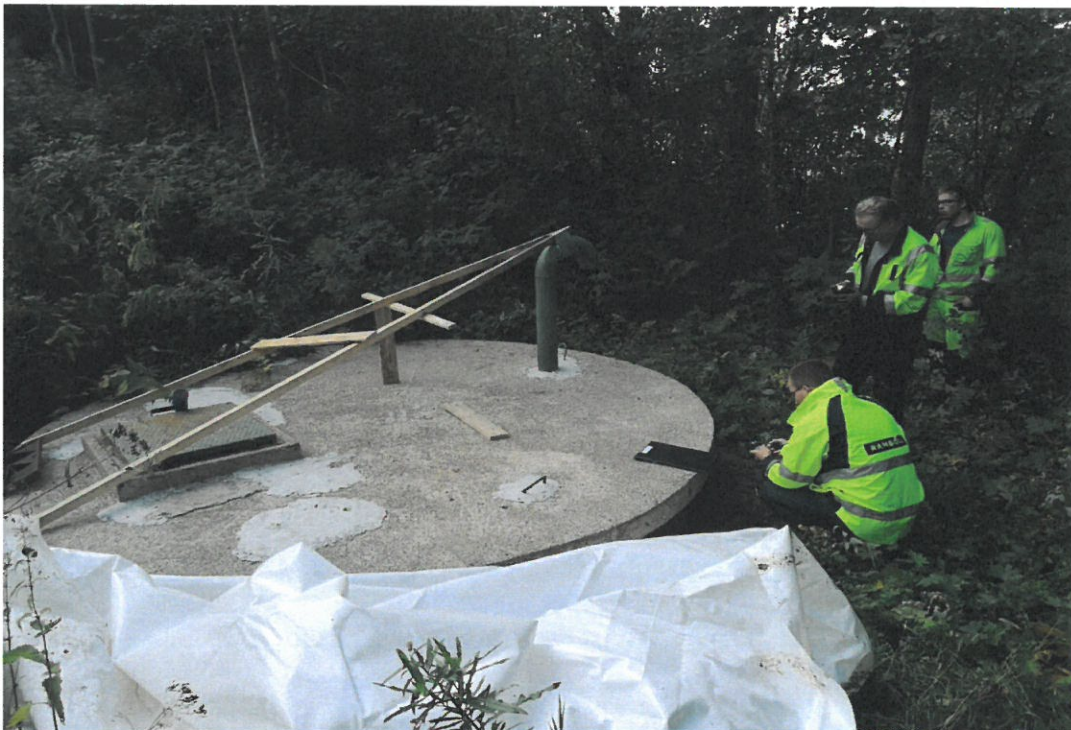
Kuva 4. Voudinniemen ottamon saneerauksen suunnittelua. Kuvassa Rambollilta Jussi Kivilahti ja Vesihuoltoilta Timo Lehtonen ja Jarno Mattila
