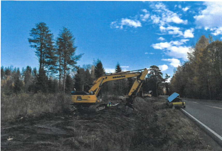
Kuva 3. Yllä kuvia Heikkilänmutkan alueelta uuden runkovesijohdon rakentamisesta
