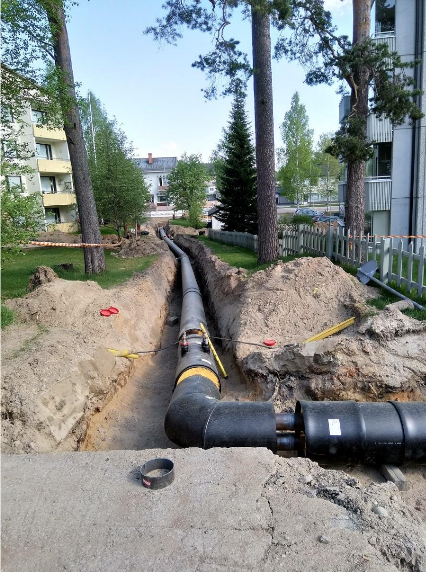
Kuva 1. Uusi runkolinja rakenteilla Karhumäentie-Koulutie välille
