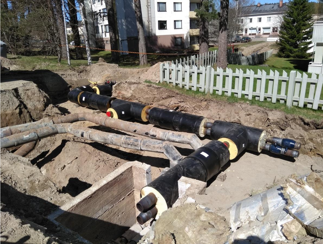
Kuva 2. Karhumäentien vanhaa ja uutta kaukolämpölinjaa
