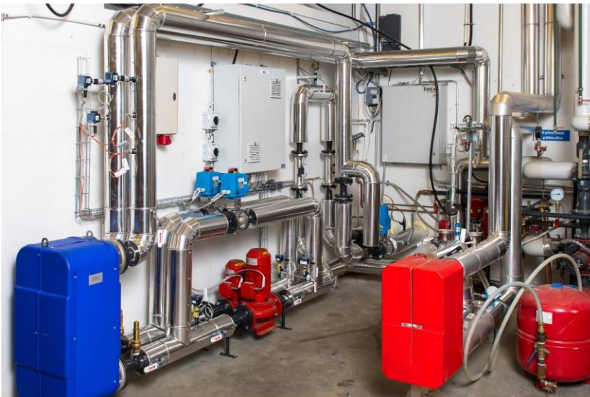
Kuva 2. JAMK:n kaksisuuntainen kaukolämpöjärjestelmä
