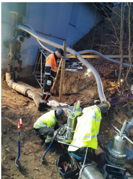
Kuva 5. Myllyperän lämpölaitokselta lähtevän linjan korjaus paineellisena
