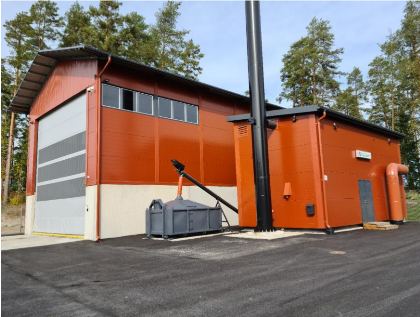
Kuva 1. Tarvaalan 1 MW lämpölaitos
