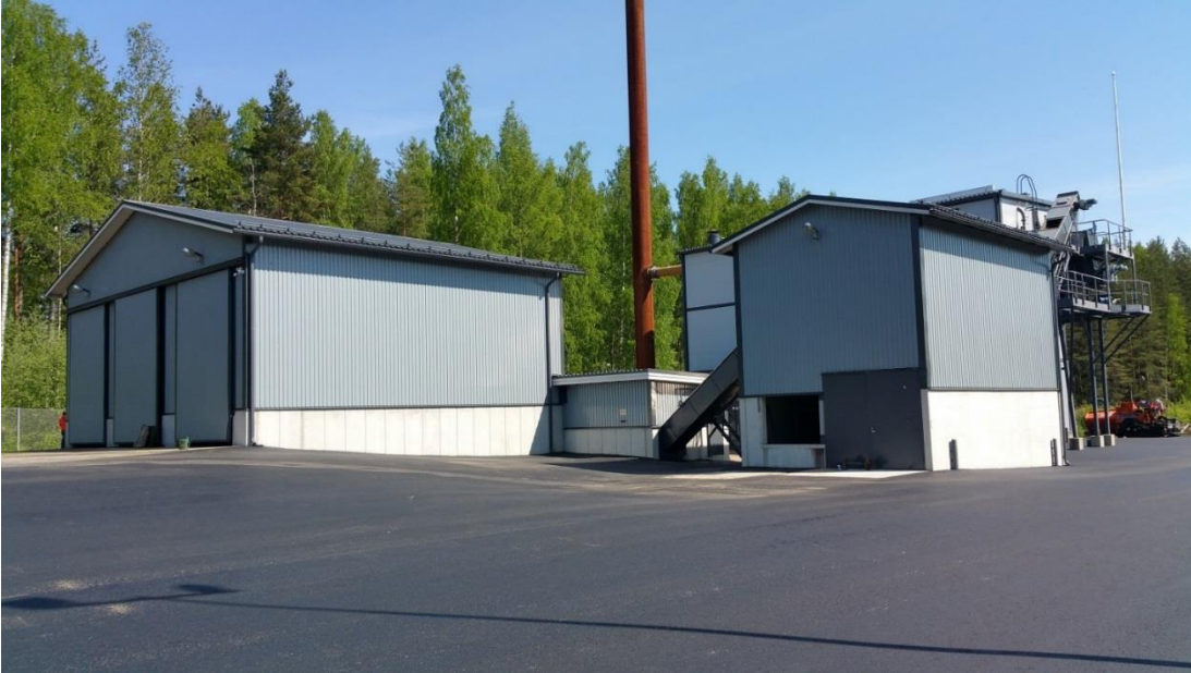
Kuva 2. Aseman KPA2-lämpölaitoksen pihan asfaltointi (Kuva: Tuomo Vilkkilä 2016)
