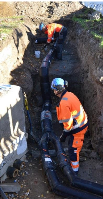
Kuva 3. Verkostorakentamista Heräjärvenkoulun kentällä. Kuvassa kaukolämpöasentajat Kimmo Kinnunen ja Päiviö Ikonen (Kuva: Tiina Toivonen 2016)
