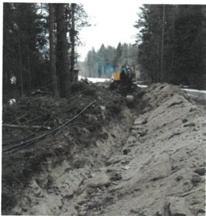
Kuva 2. Kolsan vesijohtotyömaa. Kuvassa urakoitsija Pasi Lehtonen kaivinkone. (kuvaaja: Tuomo Vilkkilä 2016)
