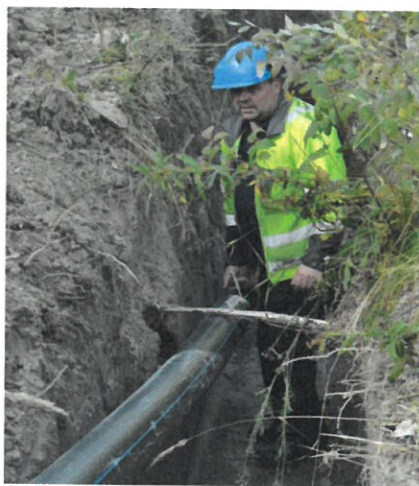
Kuva 4. Putken asennusta Hietalahden verkostotyömaalla. Kuvassa vesihuoltoasentaja Vesa Vääräjärvi (kuvaaja: Tiina Toivonen 2016)
