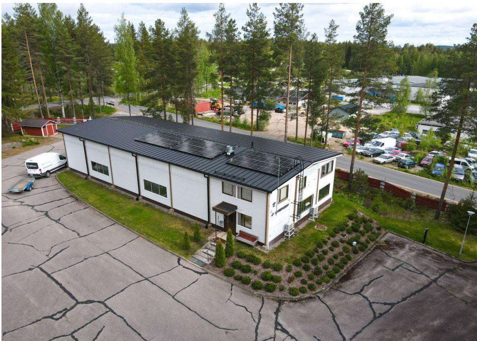
Kuva 2. Toimistohallin katolle asennettu aurinkovoimala
